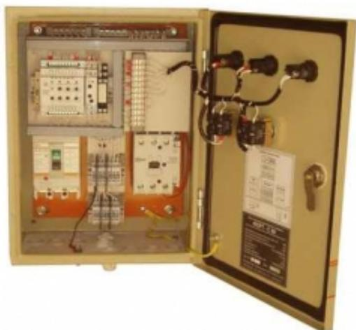
Предназначен для коммутации силовых цепей электродвигателя насосного агрегата и постоянного контроля параметров сетевого напряжения и действующих значений фазных/линейных токов асинхронного электродвигателя (ЭД) мощностью от 10 до 80 кВт. БС осуществляет полную и максимально эффективную защиту электродвигателя отключением от сети и/или блокировкой его пуска в следующих случаях:
